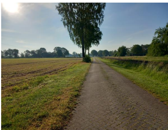
Abb. 12: Straße entlang der Bahnstrecke (Blickrichtung Südost).
